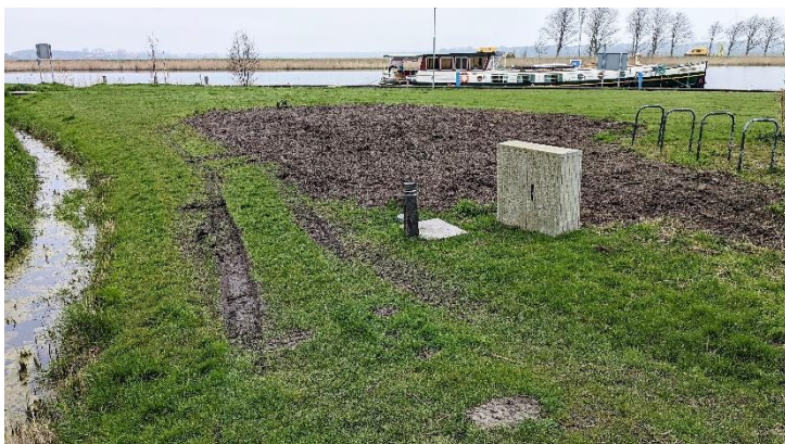
De gemeente Hollands Kroon heeft het bouwterrein van de winterstalling al ontdaan van opslag. Dit zijn struiken en enkele boom. Een wifi-paal en een stroomkast zijn ook al verplaatst.
