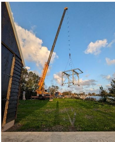
De portaalkraan wordt geplaatst.
