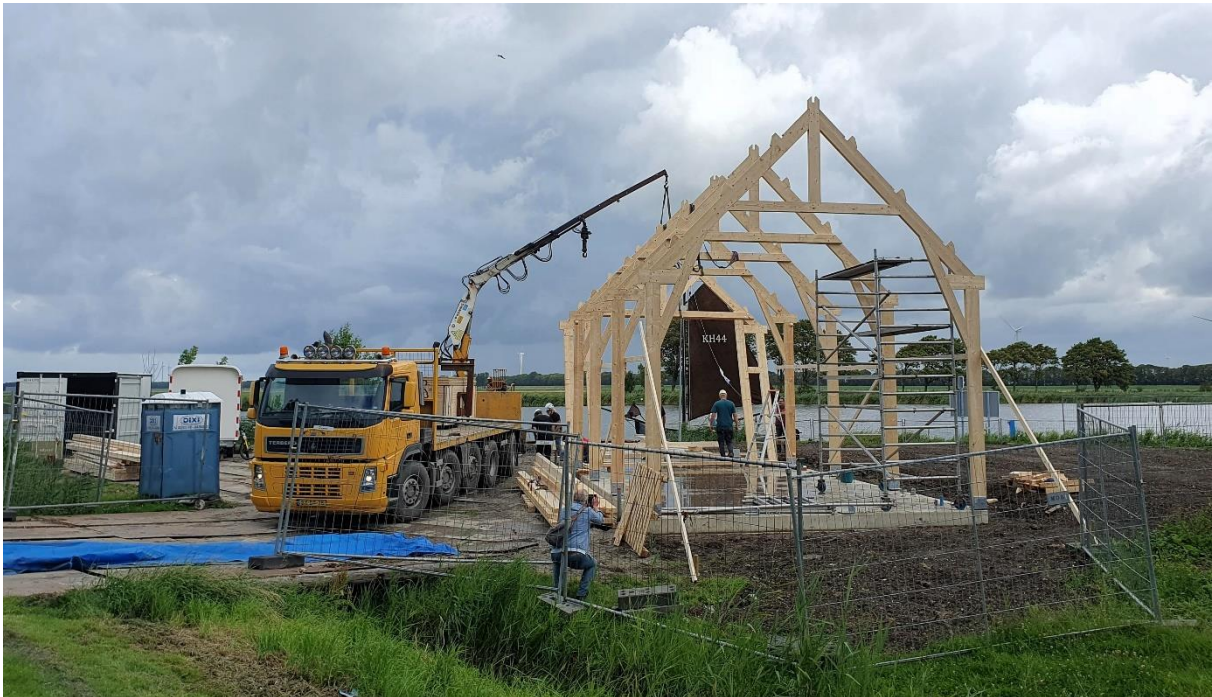
De bouwplaats op 26 juli. De spanten worden opgericht. De vrachtwagen van de firma Kuijper is een onmisbaar hulpmiddel. Voor 'het plaatje' is de jol – waar we het voor doen – op de achtergrond afgemeerd.
