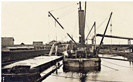
Baggerwerkzaamheden als onderdeel van de Zuiderzeewerken.
